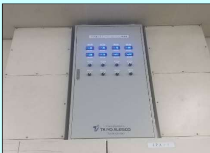
<TKS制御盤設置>
